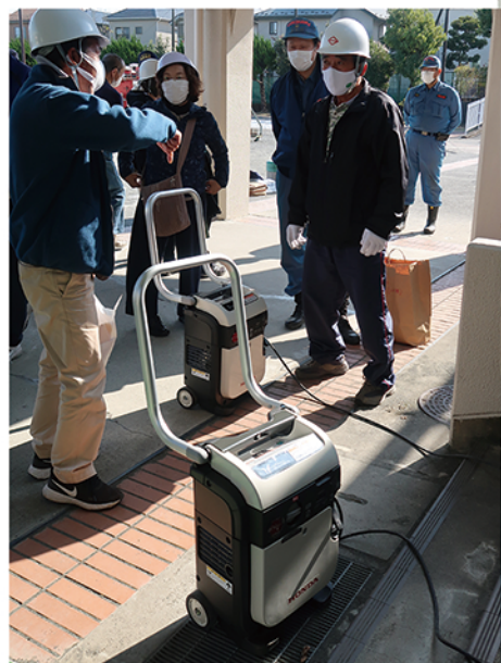
【発電機・投光器】消防団の皆さんと動作確認をしました。
