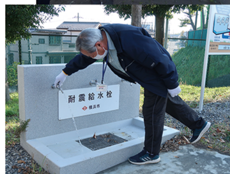
【給水栓の確認】
